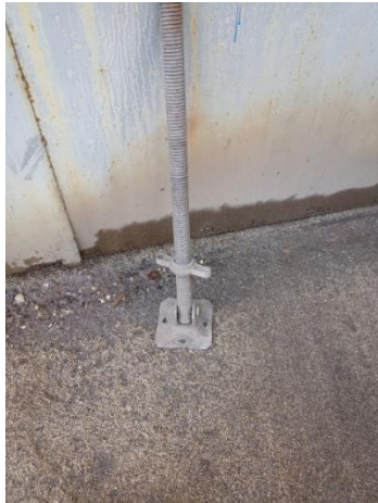
Rys. 1. Stopa śrubowa wahlliwa
