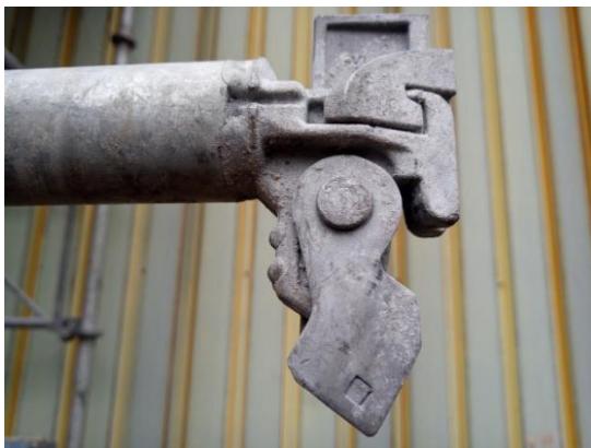
Rys. 2. Złącze zamkowe w pozycji otwartej
